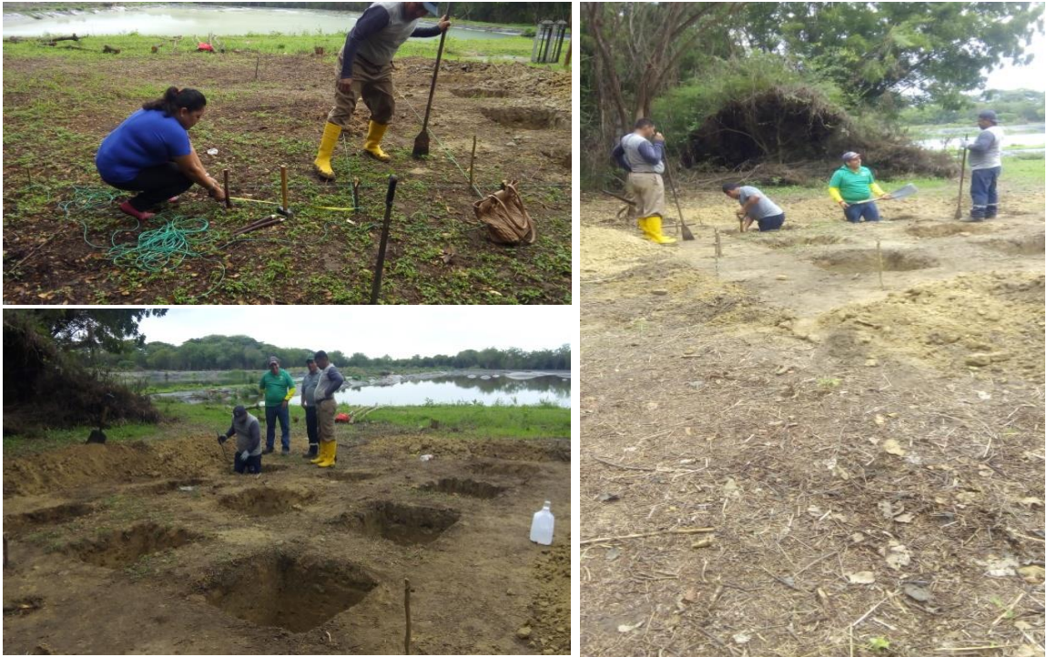
Figura 3. Excavación de hoyos para los tratamientos
