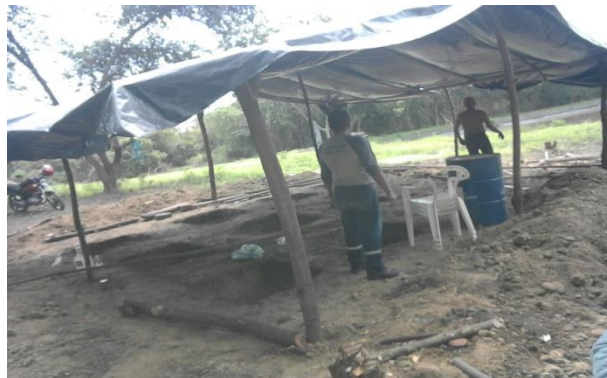
Figura 4. Colocación de una cubierta provisional
