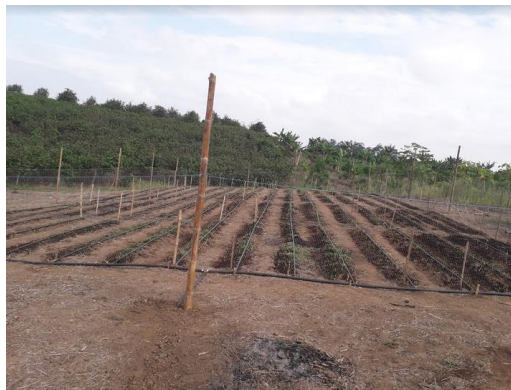
Elaboración de surcos, instalación de riego por goteo, medición de las parcelas y balizado de parcelas.
