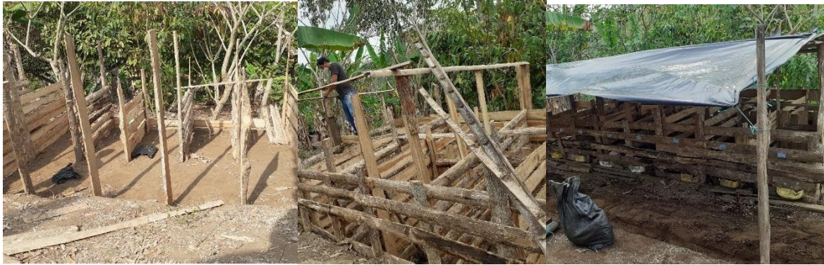
Figura 2. Elaboración del cerramiento.
