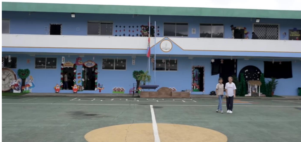
Figura 4 Instalaciones de la escuela de educación básica Montessori
