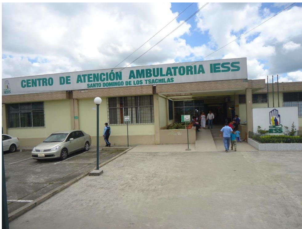
Foto 7 del edificio del Centro Atención Ambulatoria IESS Santo Domingo.
