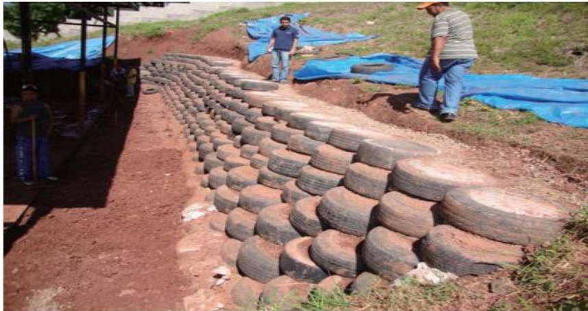
Figura 4.- Muro de contención.
