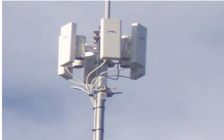
Figura 4.5 Instalación de Antena Receptora Nano Station M5, 27 dBi en la terraza de la Casa donde funciona el CIBV Los Pollitos.
