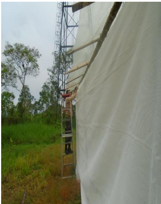
Figura 4. Colocación del sarán
