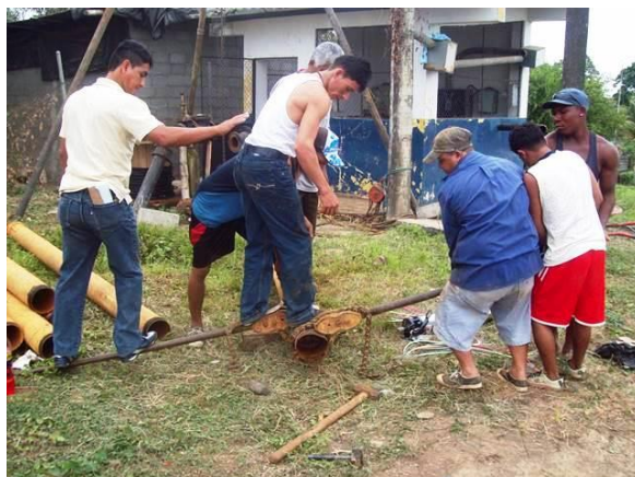
TRABAJOS EN LA PLANTA DE TRATAMIENTO
