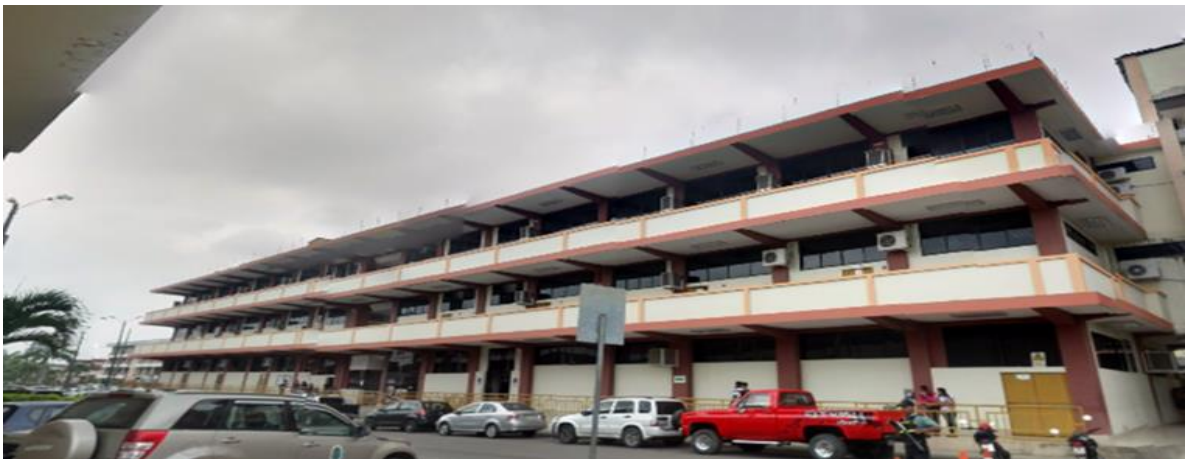
Figura 15. Edificio Facultad Ciencias de la Ingeniería.
