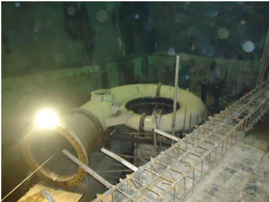
**Foto 4. Montaje de Turbina 2**
