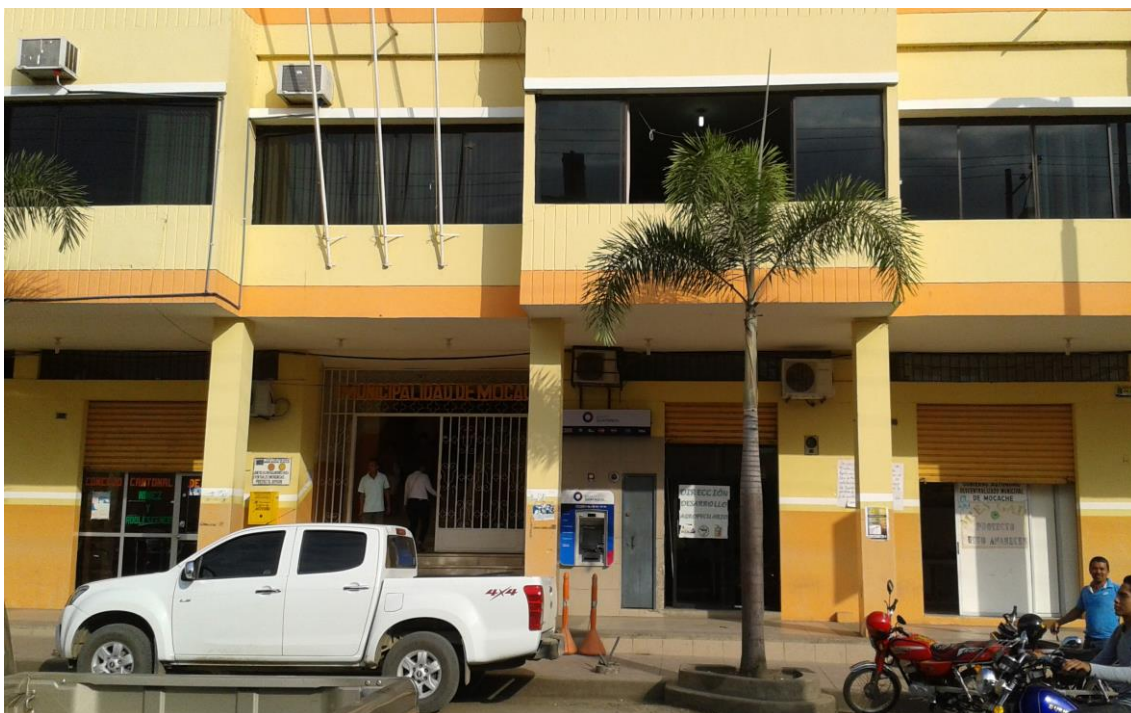
Foto 1. Edificio del GAD Municipal del cantón Mocache
