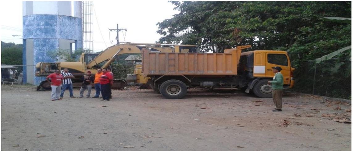
Fotos 7-8 y 9. Parte del equipo caminero del GAD Municipal del cantón Mocache
