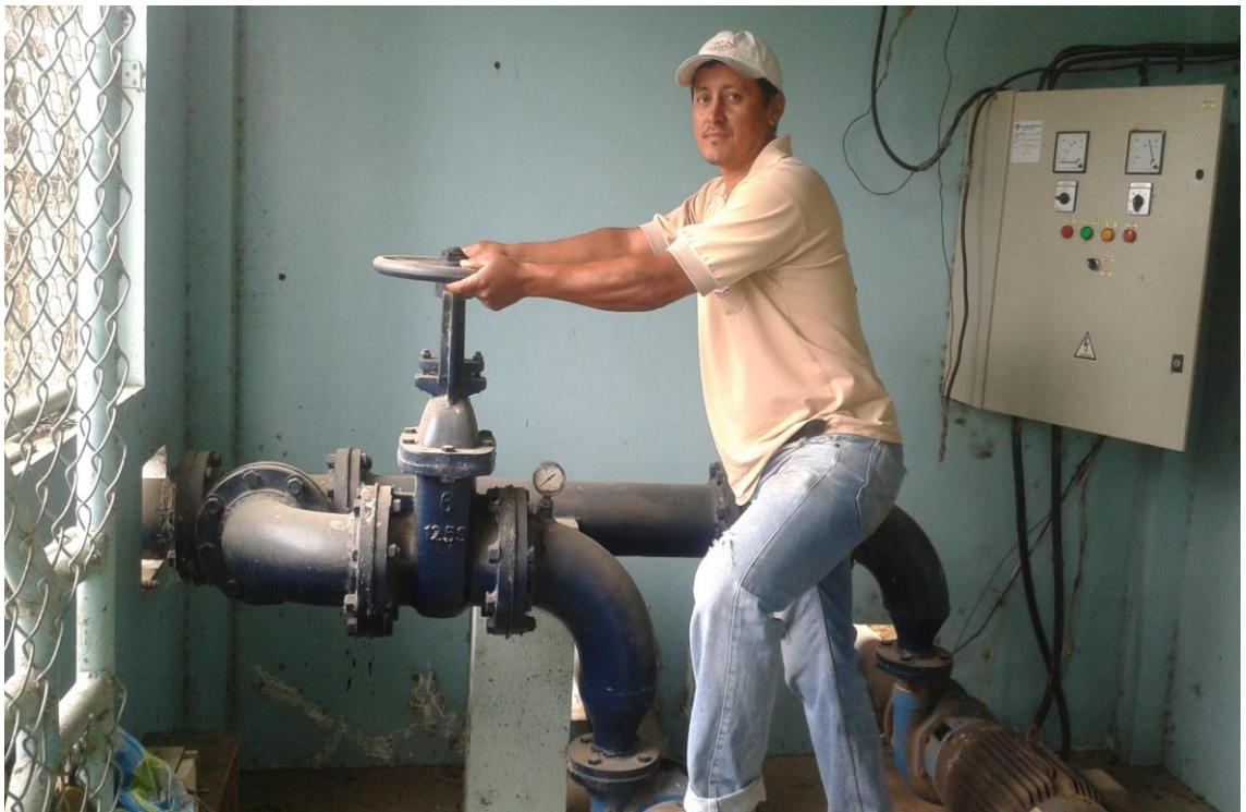
Foto 6. Obrero José Monte Bustamante, de OO.PP Departamento Agua potable y Alcantarillado, cumpliendo sus labores diarias.
