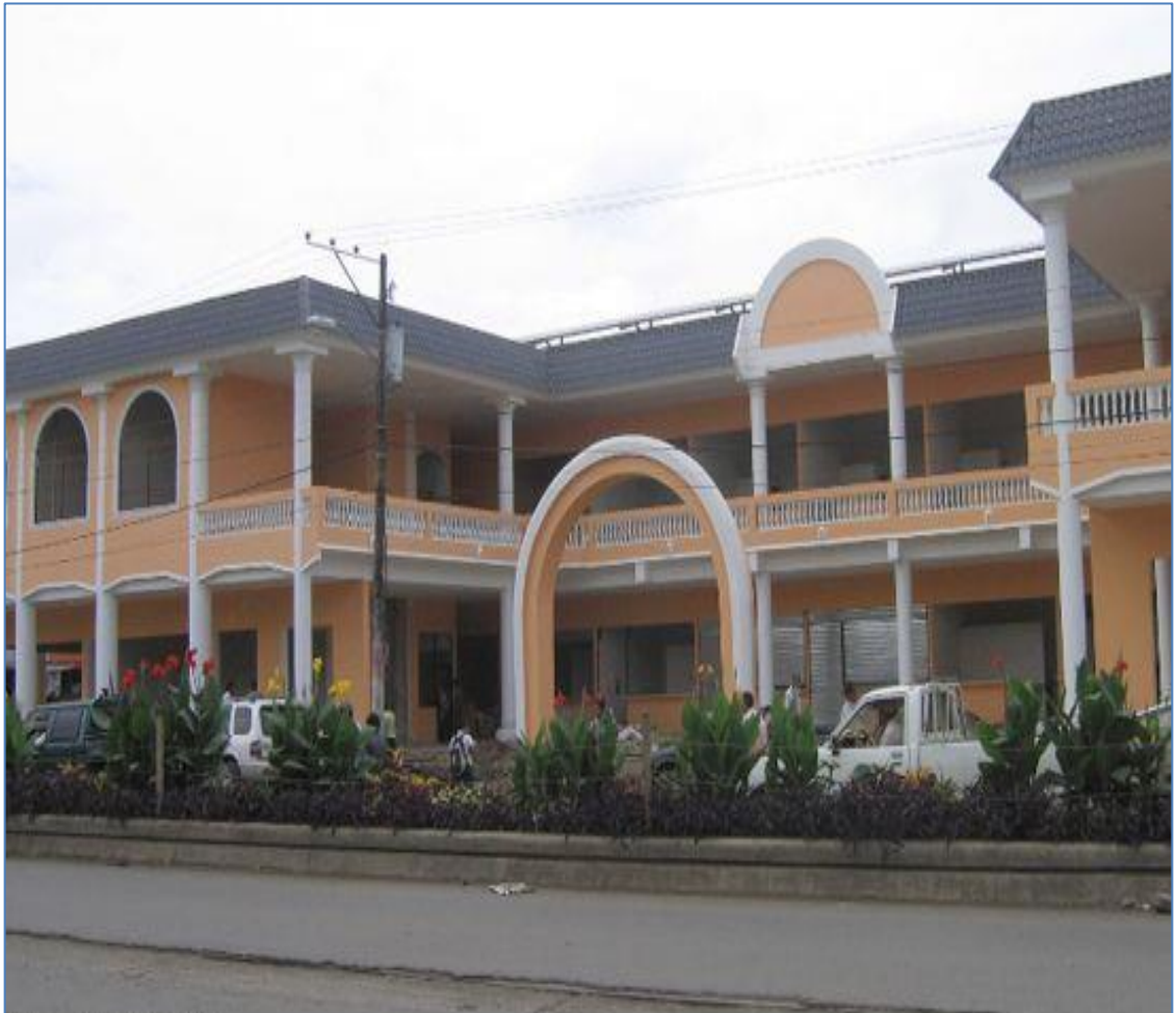
Figura N° 6. Centro Comercial Paseo del Rio – Ventanas.
