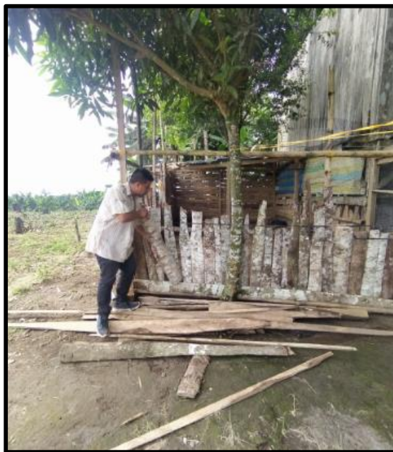
Imagen 1. Construcción de un gallinero con costaneros.
