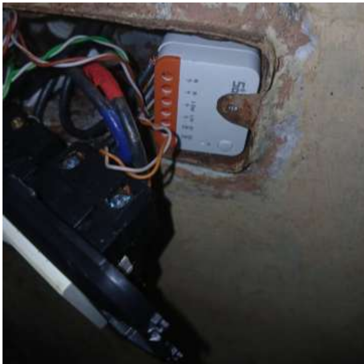
Proceso de instalación de los interruptores Inteligentes Sonoff
