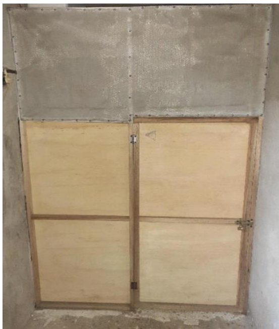
Anexo 26. Cuarto para maduración.
