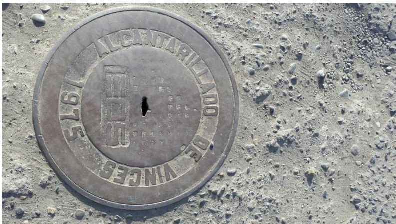
foto 13 Tapa de alcantarilla con fecha de instalación
