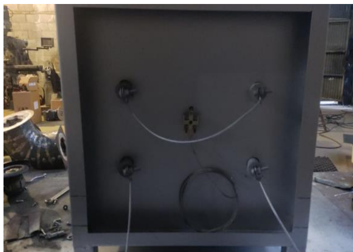
Conexión de las resistencias del horno
