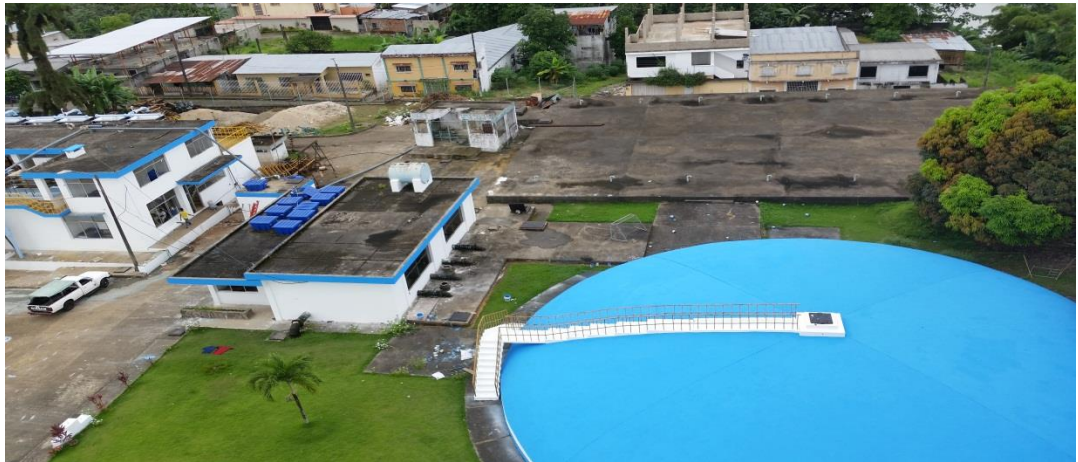
Sistema de aireación planta subterránea
