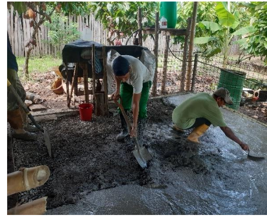
Fotografía 4 Construcción de piso
