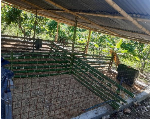
Fotografía 1 Construcción de corrales
