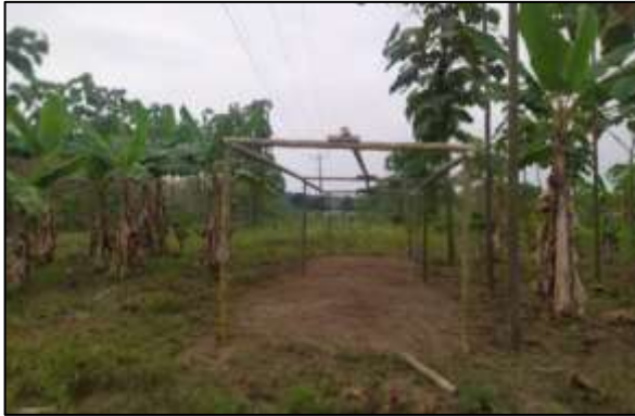
Construcción del invernadero
