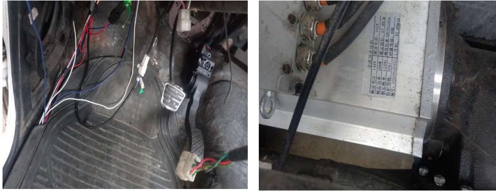
Figura 73. Conexión de cables.
