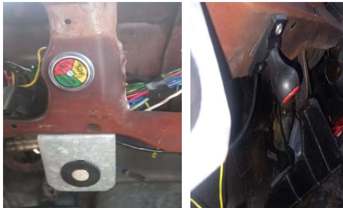
Figura 68. Instalación de controles dentro de la cabina.
