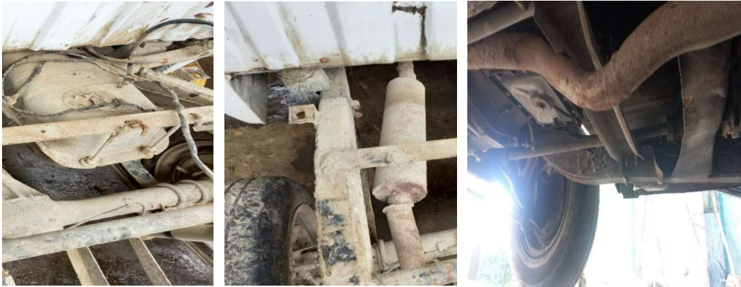
Figura 44. Desinstalación sistema de escape y tanque de combustible.
