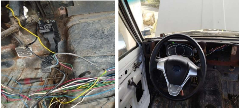
Figura 61. Instalación de pedal de aceleración y tablero.
