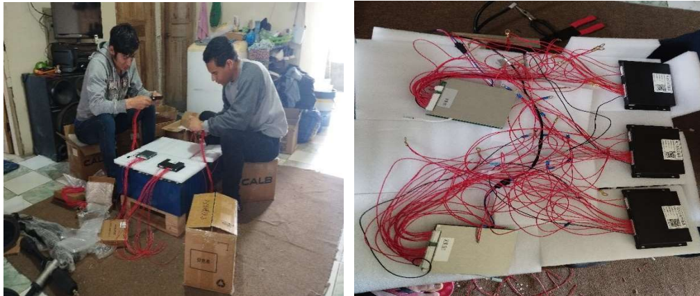
Figura 51. Conexión del BMS y los ecualizadores.
