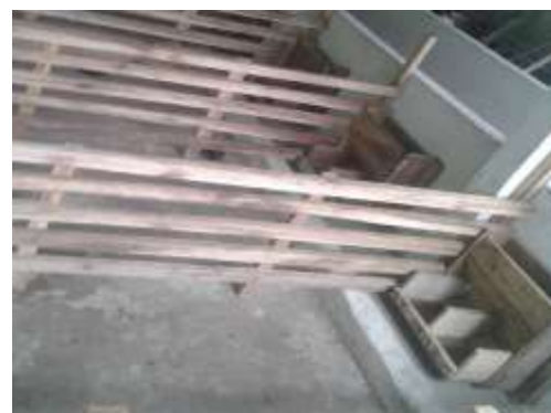
Construcción de las divisiones en el sistema de piso concreto.
