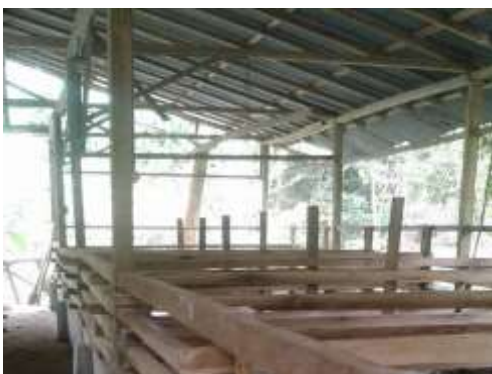
Construcción de las divisiones en el sistema de cama profunda.
