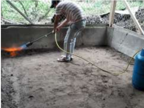
Flameada en el galpón destinado a camas profundas.
