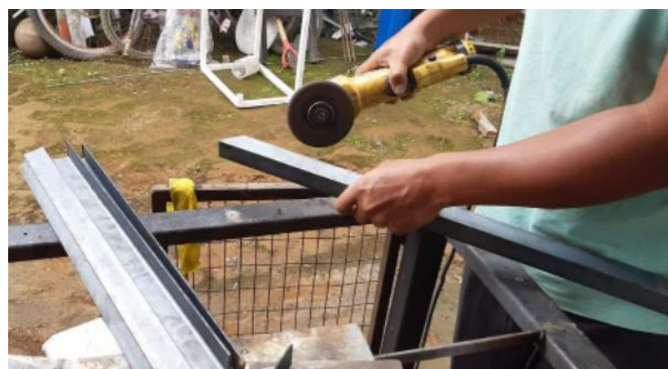
Anexo 44. Cortar los perfiles para la estructura de la máquina estampadora de cera.
