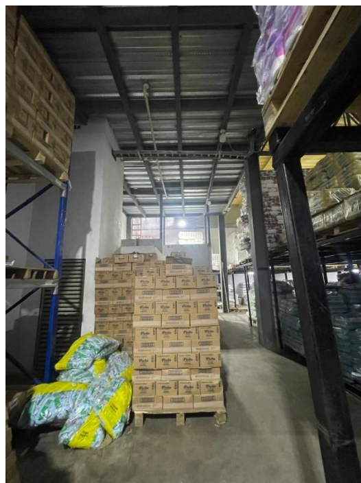
Zonas con presencia de sombras pronunciadas debido a la mala distribución de la iluminación
