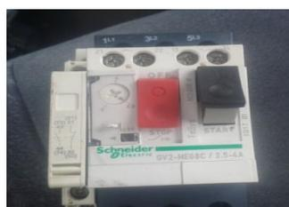
Dentro del circuito eléctrico del equipo se colocó un disyuntor eléctrico Schneider de protección térmica (2,5 – 4 A) y control por pulsador para el resguardo del motor.
