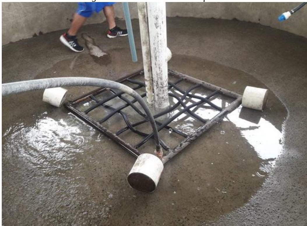
Anexo 3. Sistema de oxigenación instalado en el estaque en estudio.
