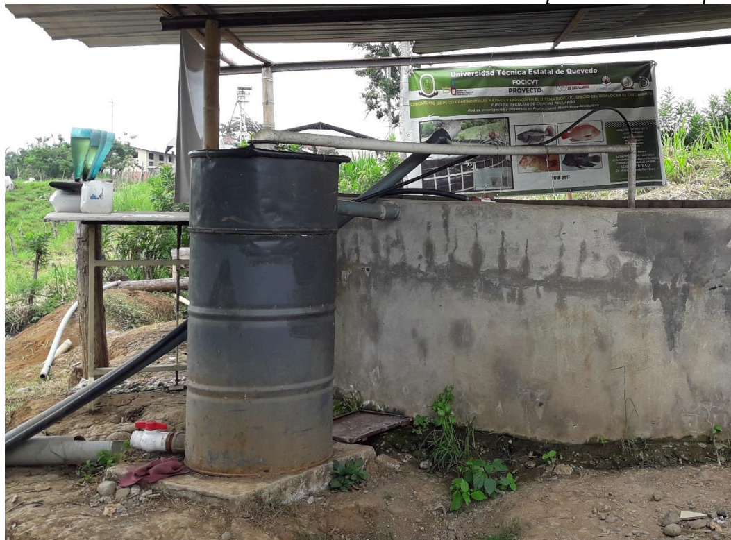
Anexo 2. Sistema de evacuación de residuos sólidos del estaque en estudio biofloc.
