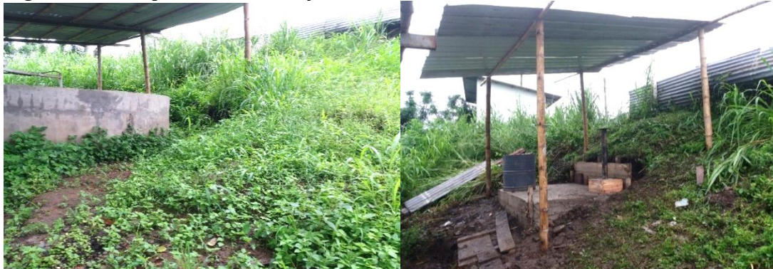
Figura 39. Base para instalación y techado
