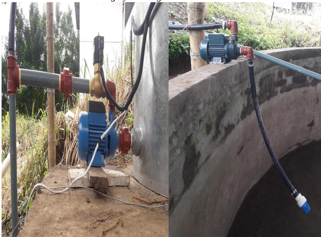
Anexo 14. Sistema de carga y descarga del calentador eléctrico.
