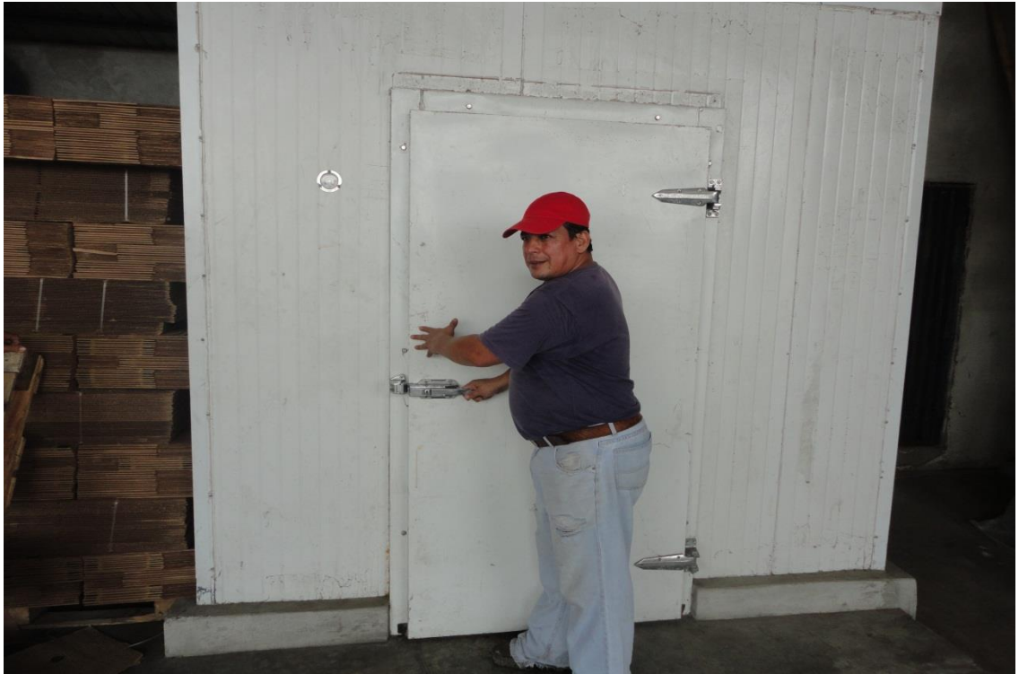
Foto 5. Cierre de la cámara de maduración
