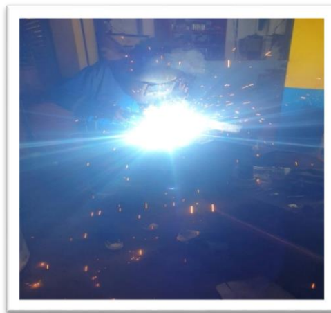
Ilustración 56. Elaboración del cordón de soldadura.
