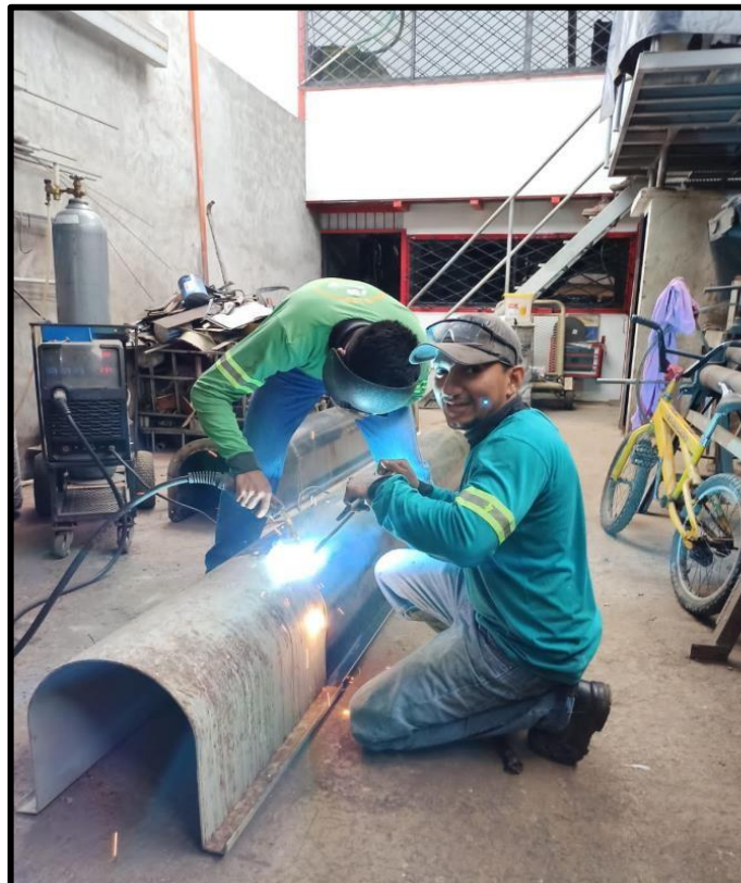
Anexo 4. Soldado de la brida al modulo
