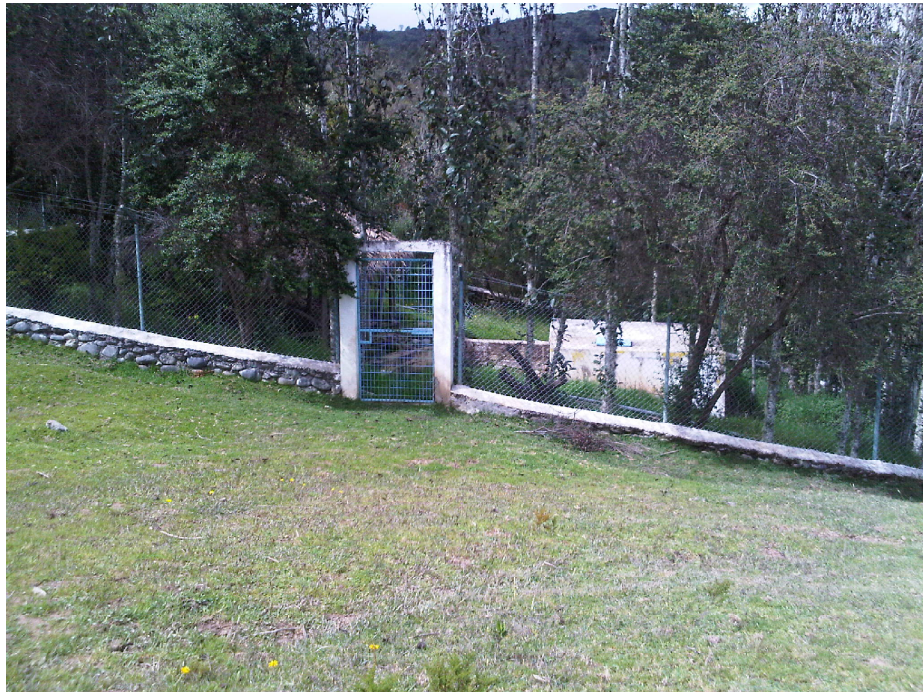
Foto N-20 Captación de Chagchacón 1
