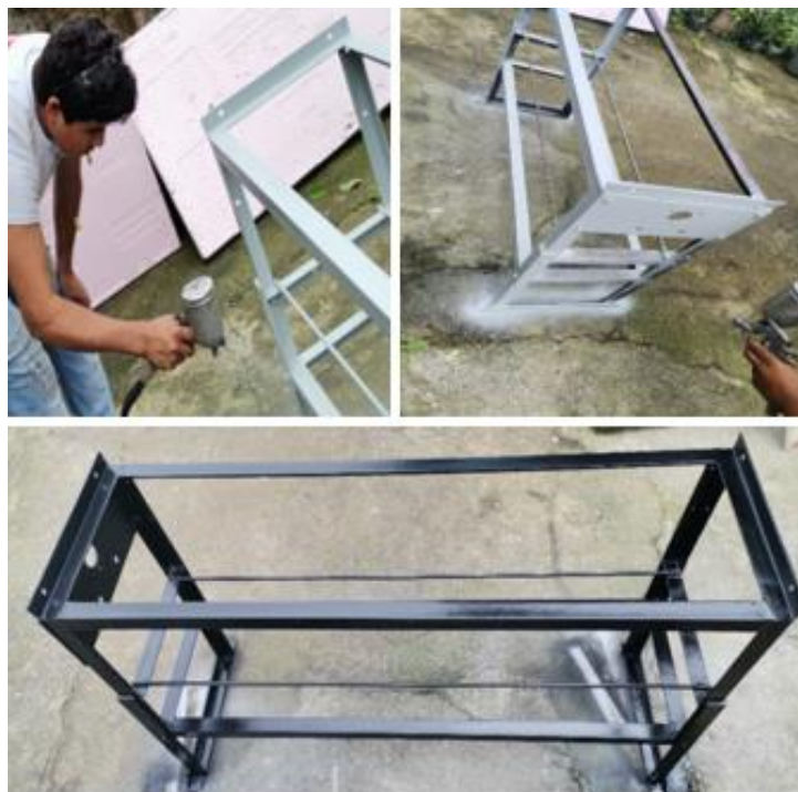
Figura 82. Estructura principal soldada y pintada.
