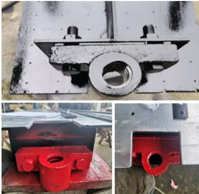
Figura 98. Colocación de las roscas de potencia en la mesa de elevación.
