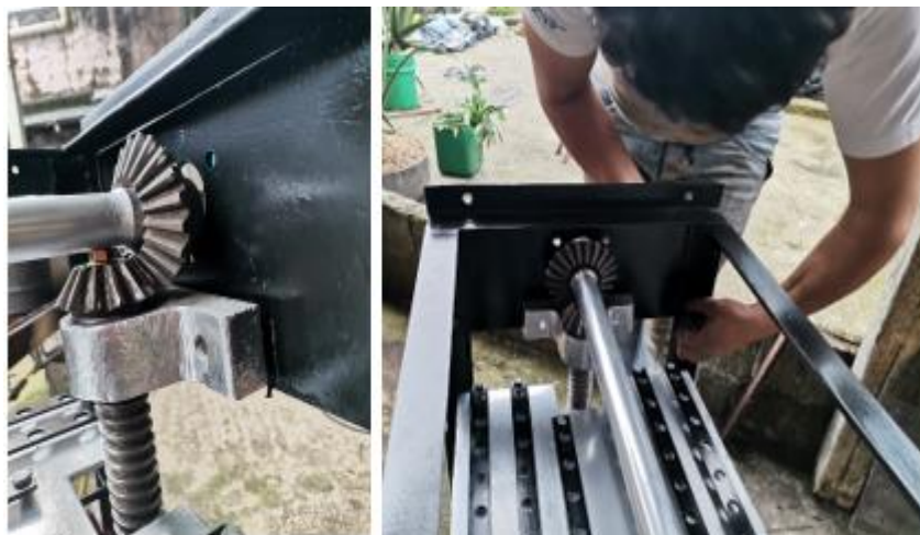
Figura 106. Colocación del soporte del tornillo de potencia.
