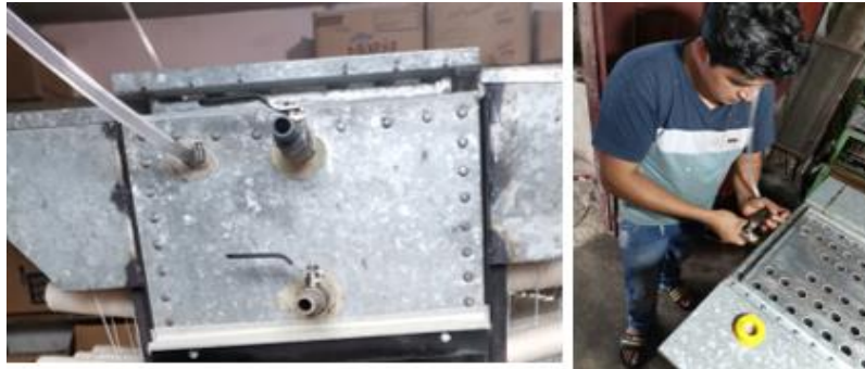
Figura 115. Colocación de llaves de paso y mangueras.
