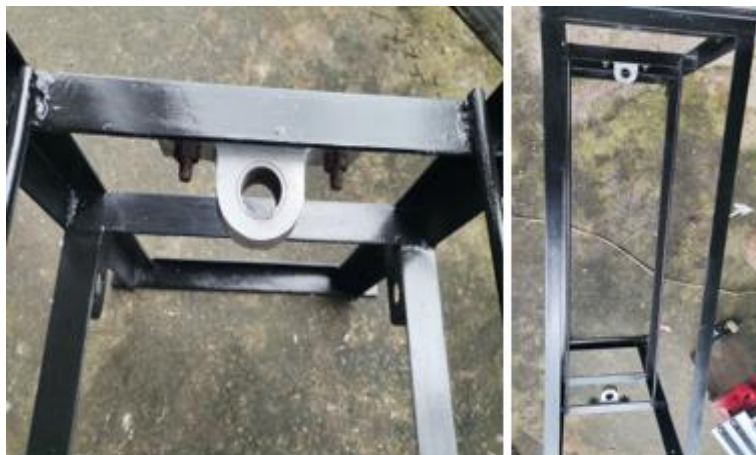
Figura 102. Colocación de los soportes secundarios en la estructura.
