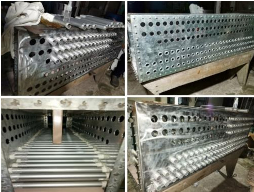
Figura 75. Colocación de los tubos de aluminio en el cajón.
