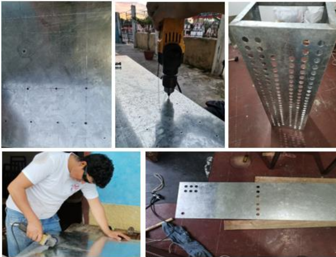
Figura 67. Medición, ubicación y perforación de agujeros para los tubos en el cajón.
