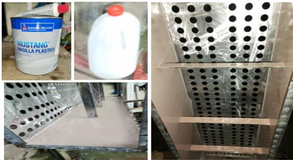
Figura 74. Recubrimiento interior de paredes laterales y platinas con mezcla de resina y masilla plástica.
