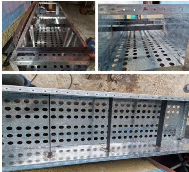
Figura 69. Colocación y suelda de las platinas de refuerzo dentro del cajón.
