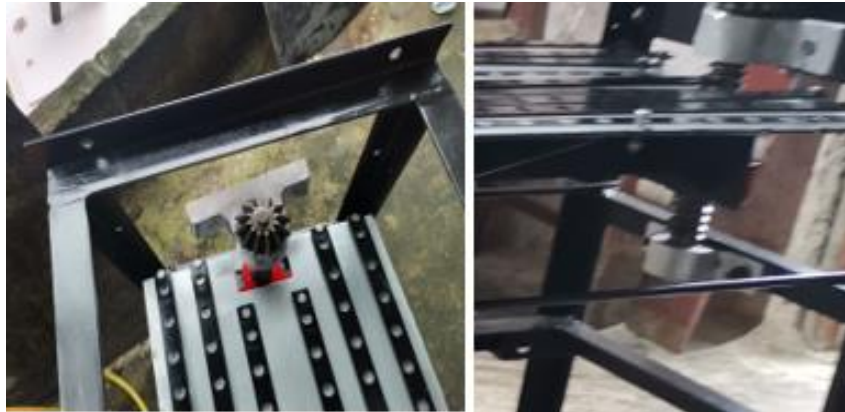
Figura 103. Montaje de la mesa en los soportes secundarios.
