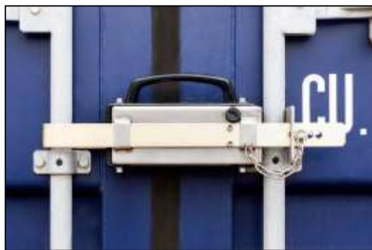
*Figura 35: Cerradura instalada en un contenedor*
