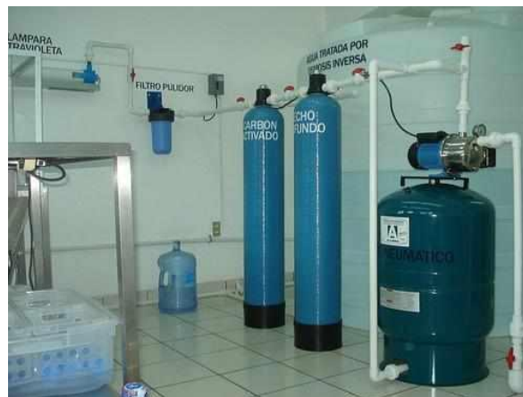
Figura 8. Equipo de filtrado de la Empresa LIQUI AGUA.
