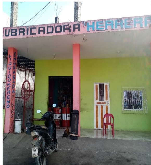
Anexo 13. Instalaciones de la lubricadora Herrera
