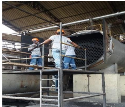
Gráfico No. 5 Trabajadores realizando mantenimiento correctivo del caldero
