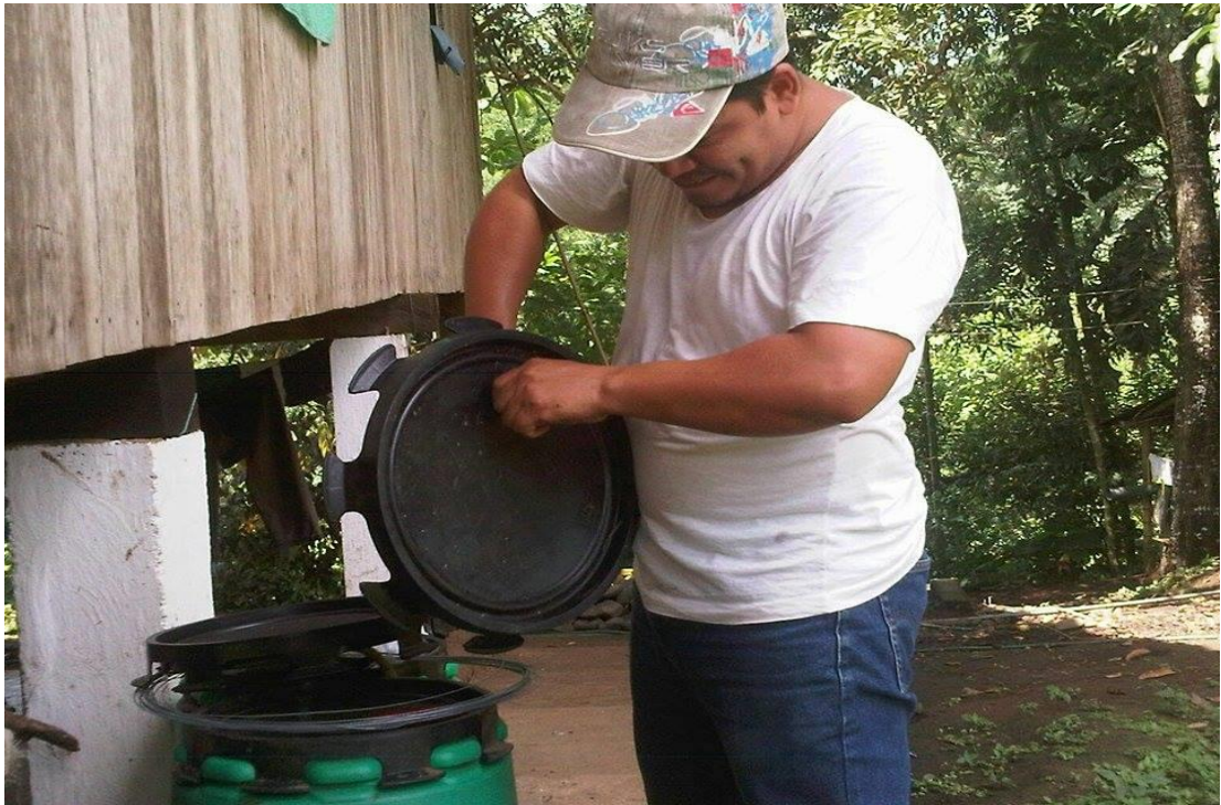
Figura 4. Elaboración de los biodigestores (orificio para manguera)
