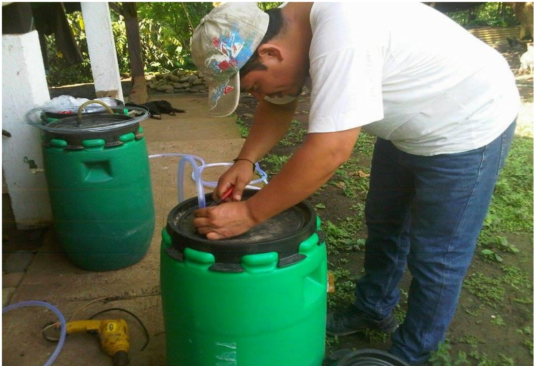
Figura 5. Elaboración de los biodigestores (colocación de manguera)
