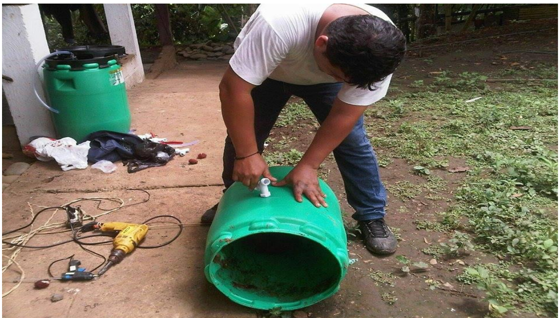
Figura 3. Elaboración de los biodigestores (colocación de llave)
