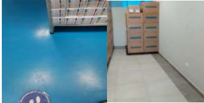
Figura 5. Descripción de los pisos y paredes de la Bodega General
