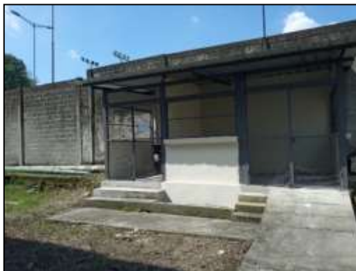
Ilustración 1 Área designada para Almacenamiento temporal
