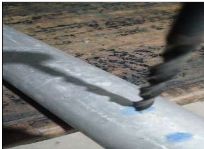
Figura 34. Dimensionado de perforaciones para adaptación de selector.
