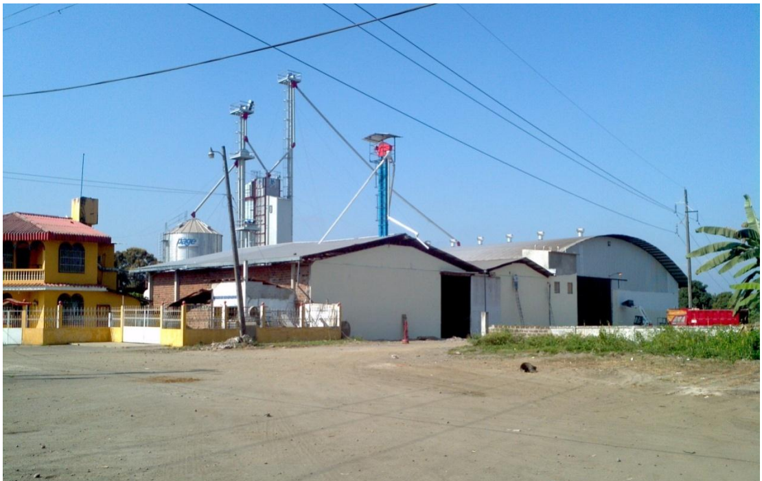
Foto 10. Centro de acopio Morejón - El Empalme
