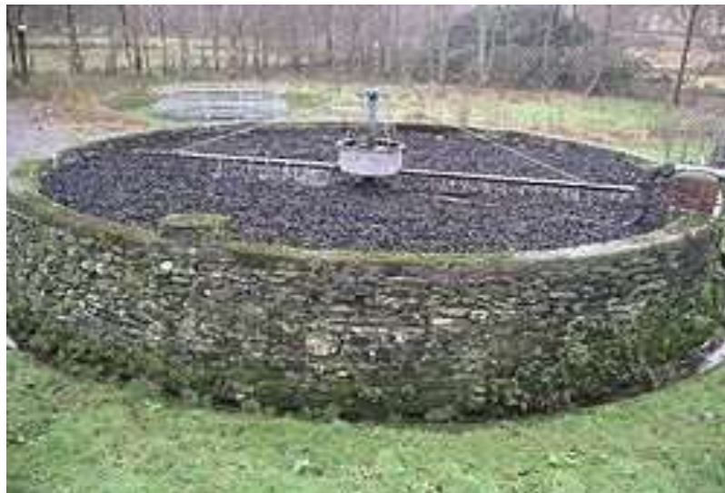
Figura 2.4. Lecho bacteriano aerobio en una planta rural.
