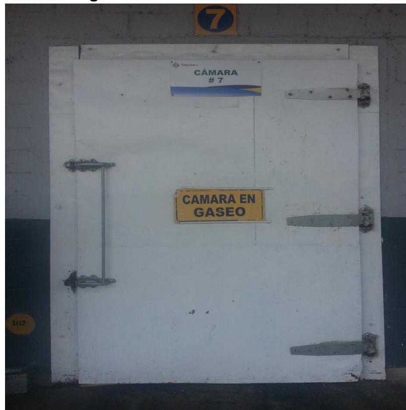
Figura N° 9. Cámara de maduración
