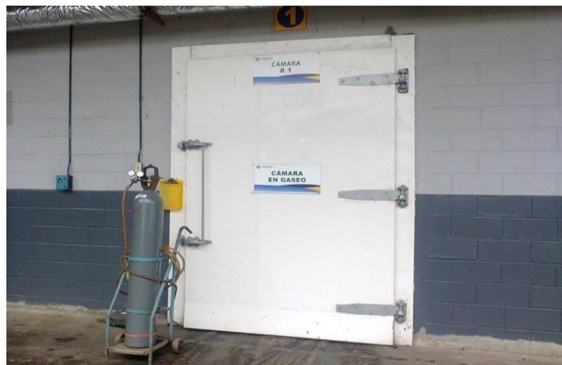
Figura N° 12. Inyección de gas etileno
