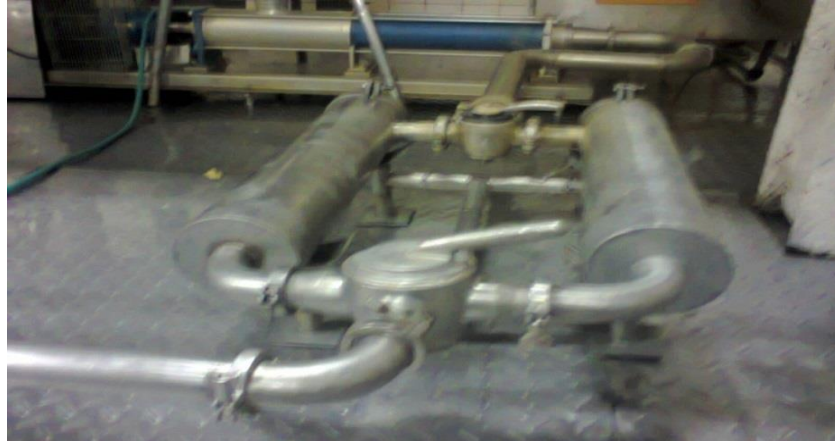
Figura N° 33. Filtración #2 de puré a la salida del finisher
