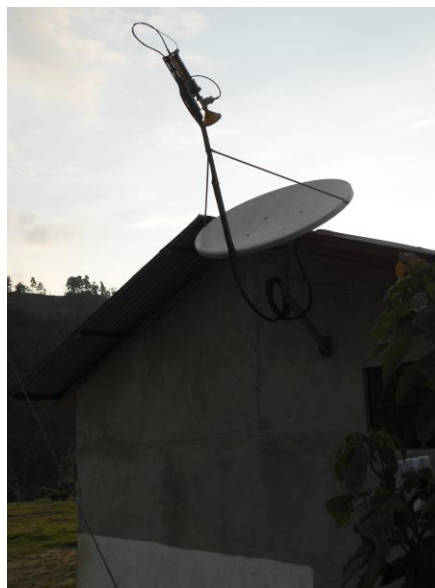
Figura 41: Montaje de la antena parabólica.
