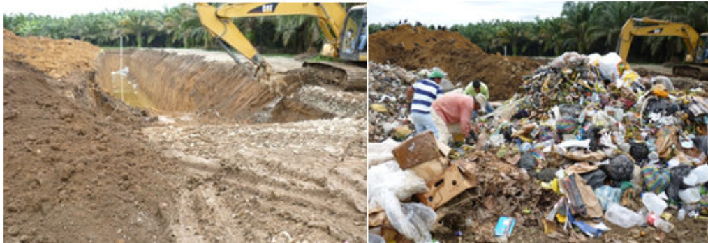
Figura 1.2. Excavación de zanjas y disposición de RSU en el vertedero.
