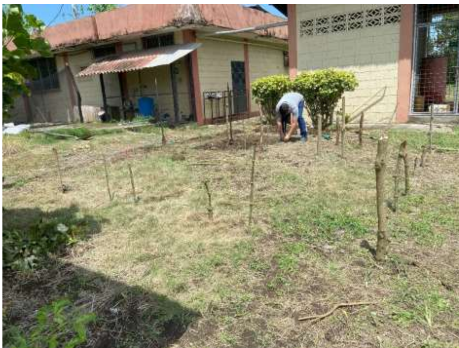
Anexo 3. Balizaje del terreno para construcción de estanques.
