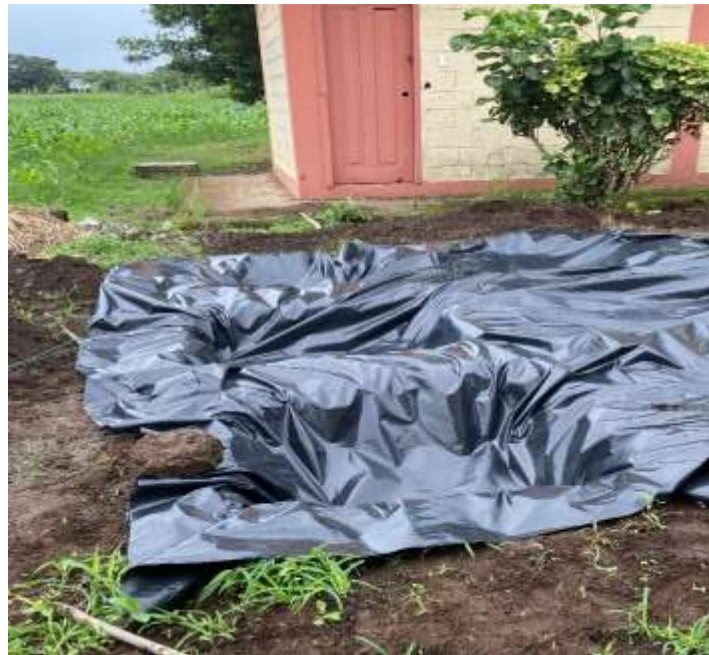
Anexo 5. Revestimiento de estanques con plástico negro.
