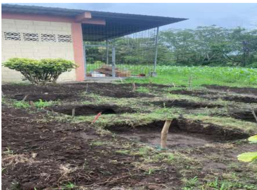
Anexo 4. Construcción de estanques para estudio de campo.
