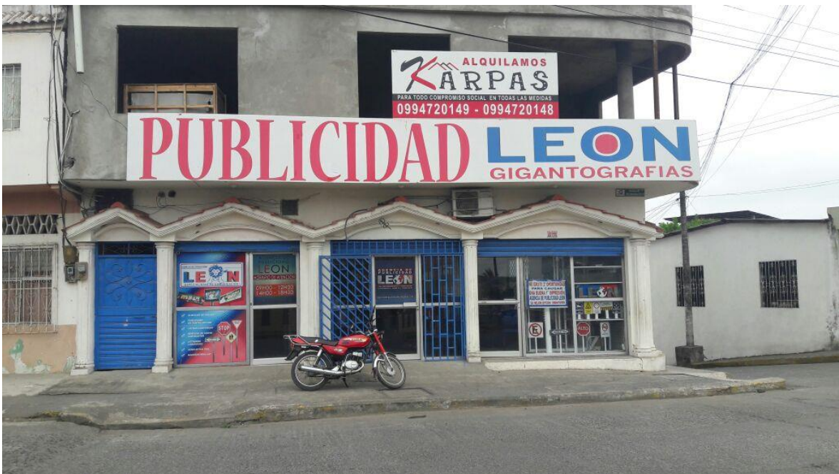
Foto 6. Instalaciones de la Agencia Publicidad León.
