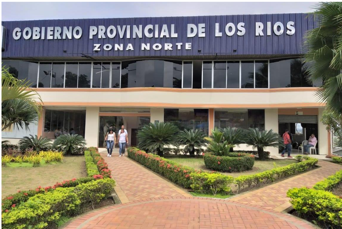
Foto 1. Instalaciones del GAD Provincial de Los Ríos.
