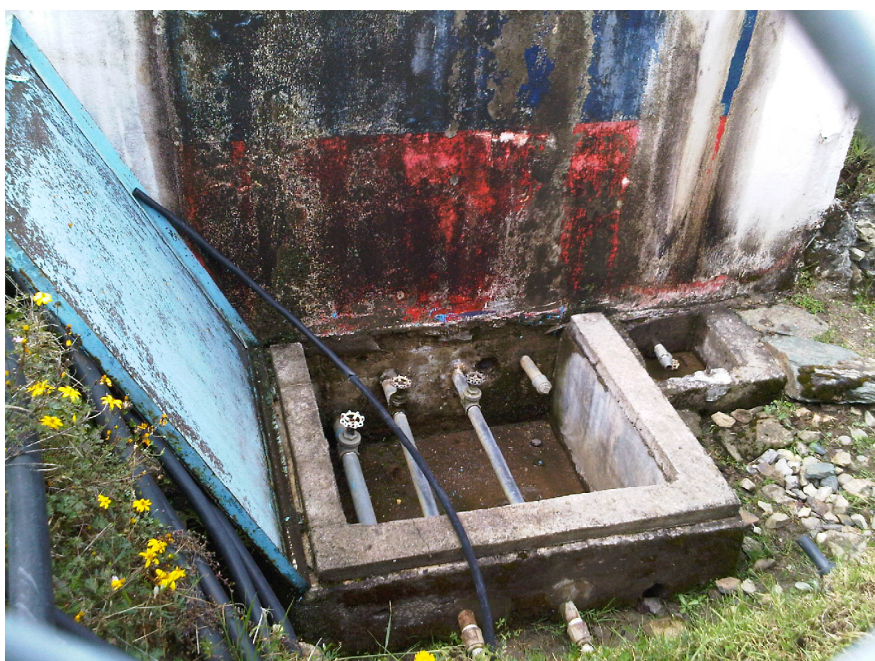
Foto No. 6 Caja y accesorios de salida de la reserva de hormigón ciclópeo
