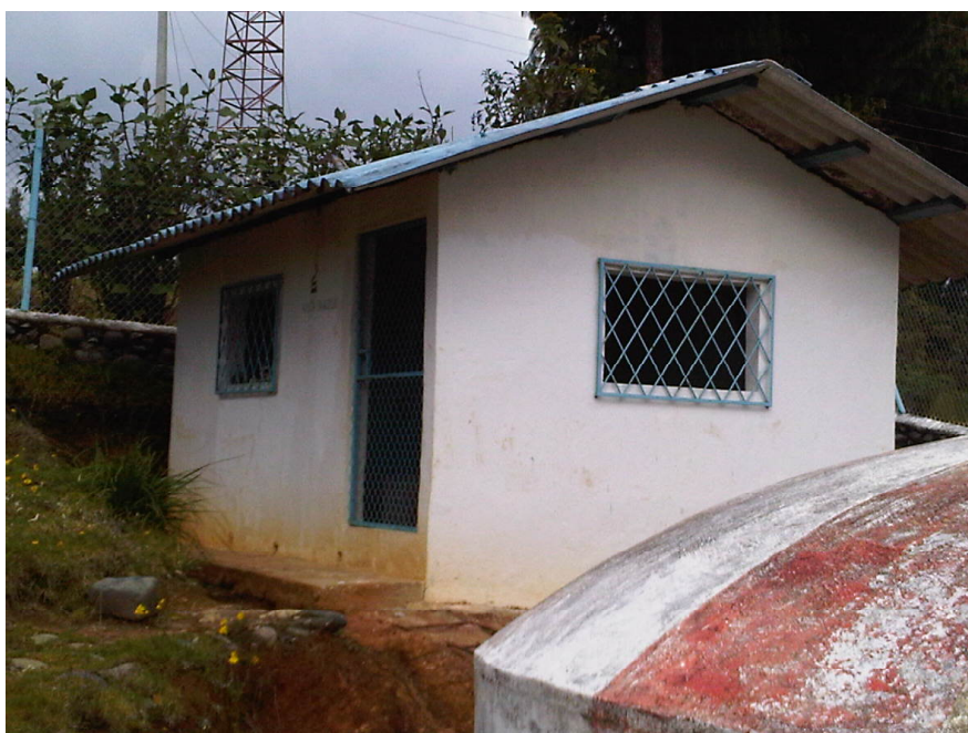
Foto No. 3 Caseta de cloración
