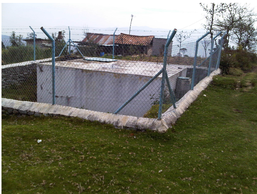
Foto No. 5 Reserva de Hormigón Ciclópeo
