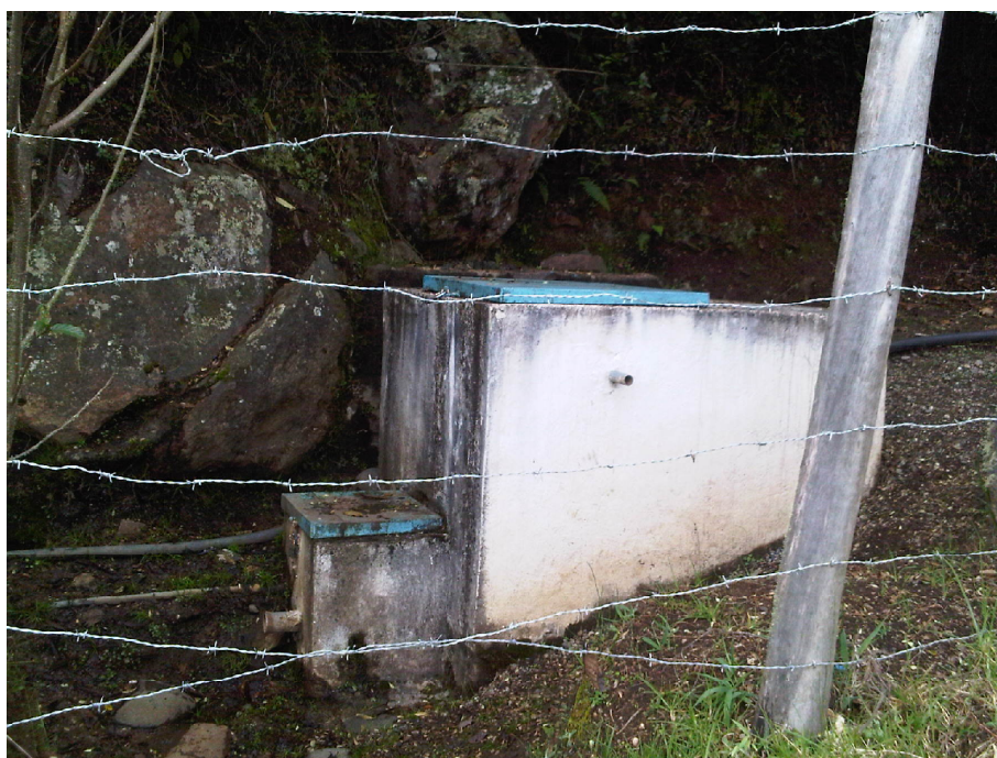
Foto N-19 Captación de Chagchacón 2
