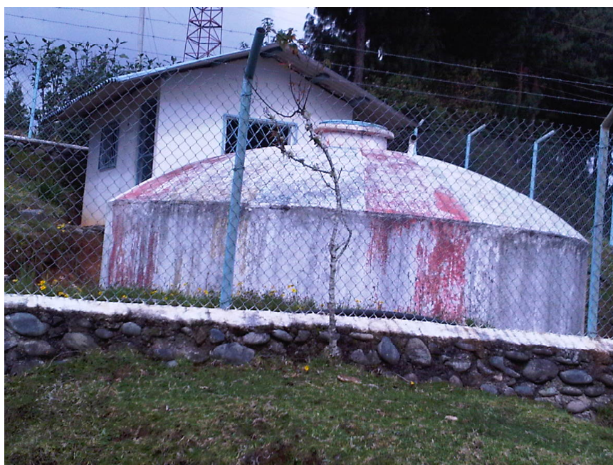
Foto No. 4 Reserva de ferrocemento
