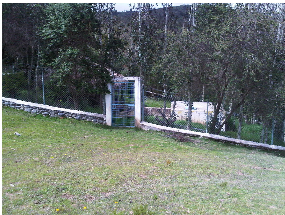
Foto N-20 Captación de Chagchacón 1
