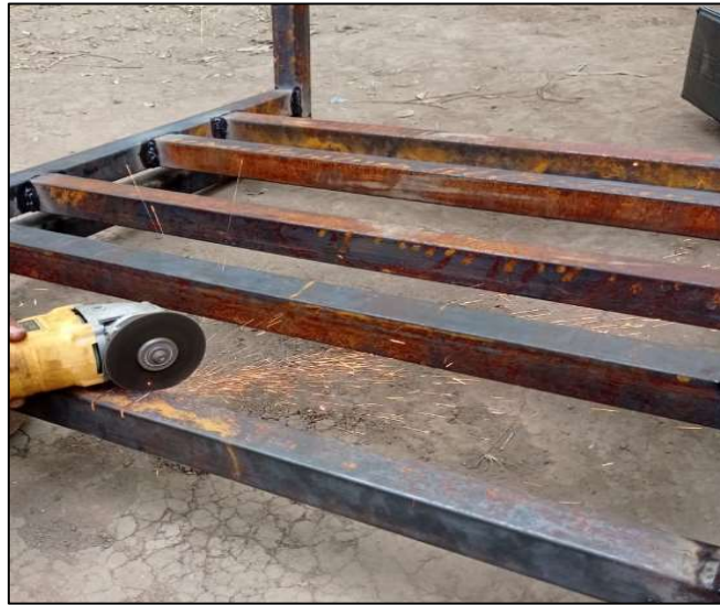
Figura 87. Pulido de soldadura.
