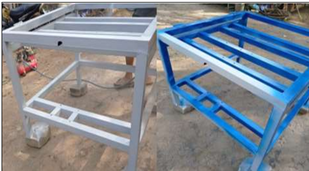
Figura 88. Pintado de estructura.
