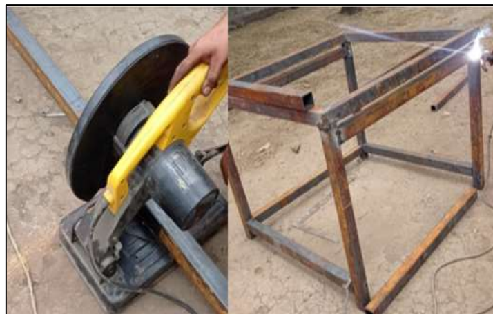
Figura 86. Corte y soldado de tubos cuadrados.
